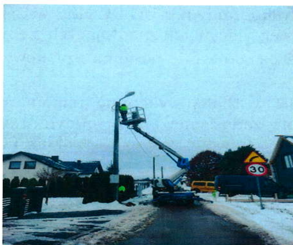
Zdjęcie 6. Budowa słupów oświetleniowych w Białej Parceli.
