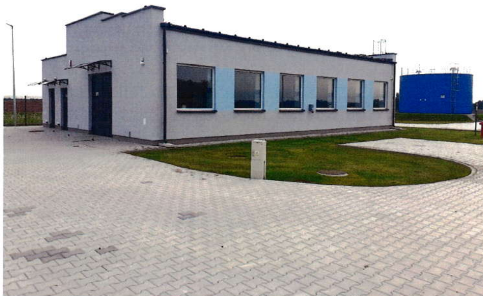
Zdjęcie 3. Budynek stacji uzdatniania wody w Naramicach.
