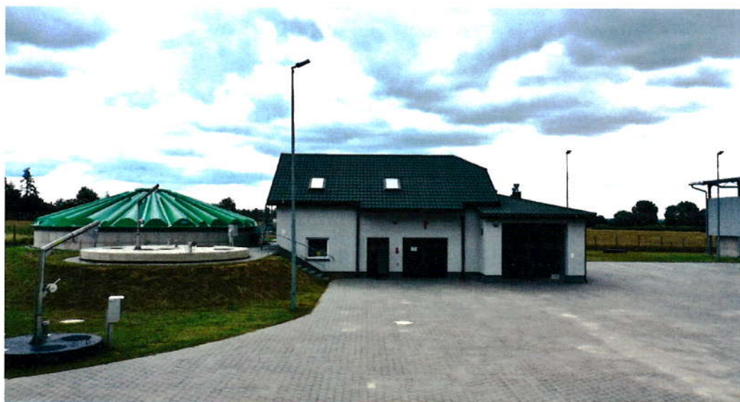
Zdjęcie 2. Obiekty gminnej oczyszczalni ścieków.
