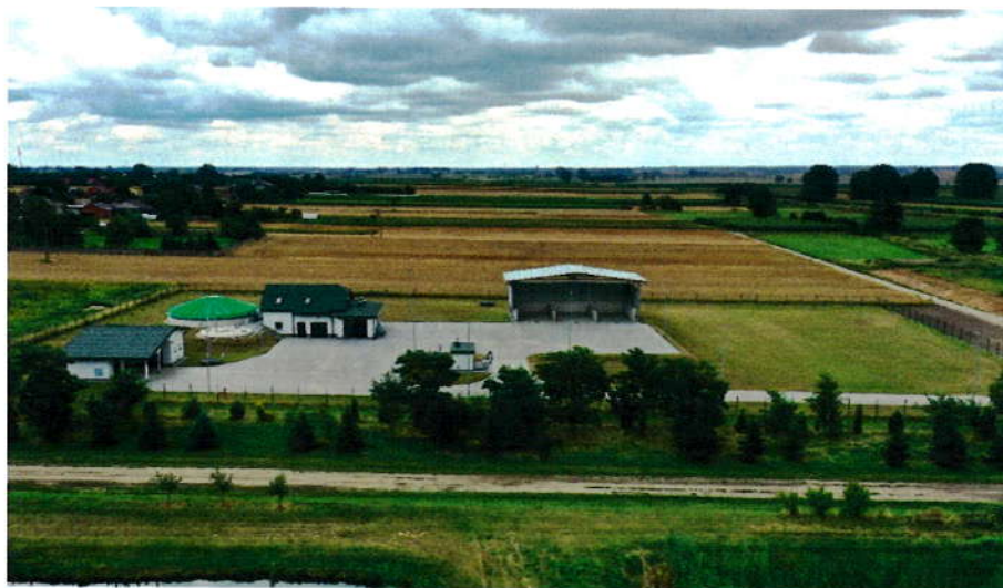
Zdjęcie 1. Gminna oczyszczalnia ścieków.
