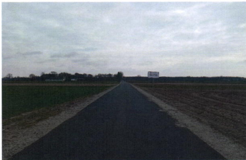
Zdjęcie 4 Przebudowana droga w miejscowości Kule.
