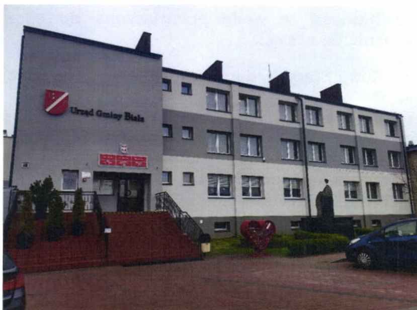
Zdjęcie 2 Budynek Urzędu Gminy Biała po termomodernizacji.
