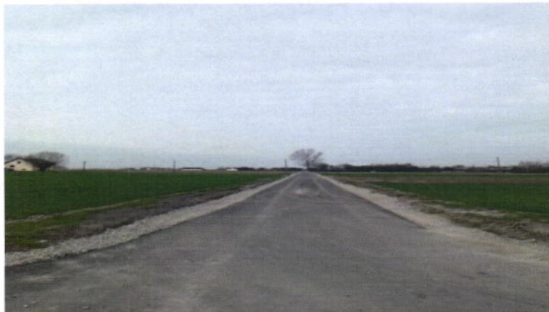
Zdjęcie 5 Przebudowana droga w miejscowości Łyskornia.
