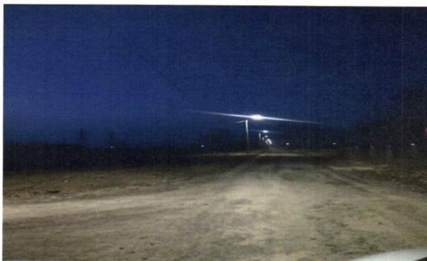
Zdjęcie 7 Wybudowane oświetlenie przy drodze wewnętrznej w Białej Parceli.
